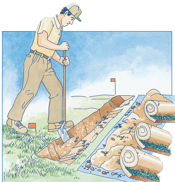
Najpierw ułóż plandekę i usuń darń, a następnie wykop rowy o głębokości 25 – 30 cm na główną instalację.
