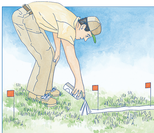
Przed rozpoczęciem wykopów użyj małych flag i farby do oznaczeń w sprayu, aby zaznaczyć ułożenie systemu nawadniania.
